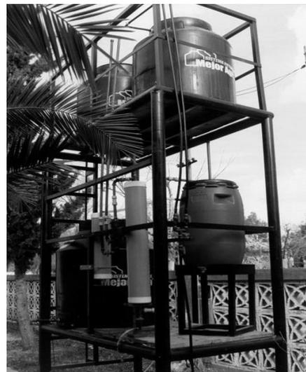
Figura 4. Planta de tratamiento por corrosión de lecho fijo de hierro metálico.
