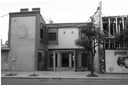
Fotografía 2. Motivación del trabajo: Daños producidos en una casa adyacente a la construcción de un edificio en altura.
