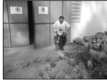
Figura 8. Triturado de Bloques de Hormigón con Martillo DeWalt de 30 kg.
