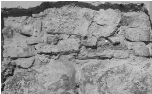
Figura 4. Cateo de muro exterior en donde se realizaron ensayos no destructivos sobre cada uno de los materiales componentes de la mampostería
