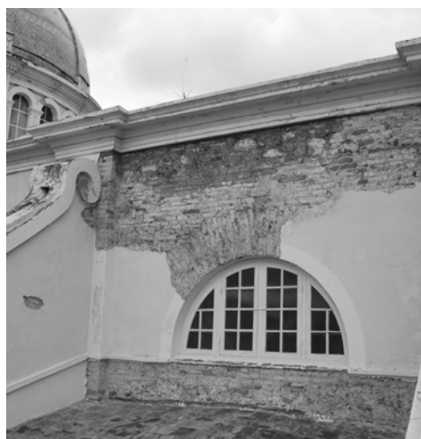
Figura 3. Sector de mampostería y arco de la bóveda de cañón de la nave central, construidos con mampostería de ladrillo
