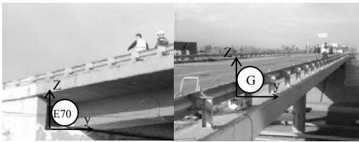
Figura 2. Puente Gobernador del Campo: ubicación de acelerómetros.
