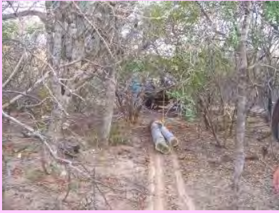
Foto C2: Línea de cable
