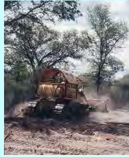
Foto S38: Desmonte con topadora
