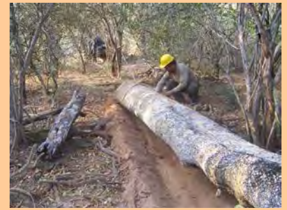
Foto P6: Realización de lo planificado
