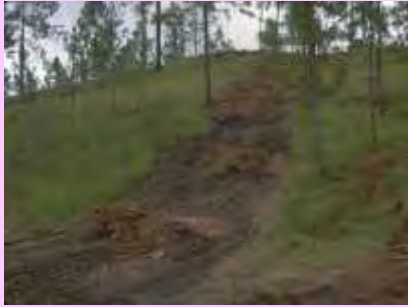
Foto 26: Vía de saca con drenajes transversales
