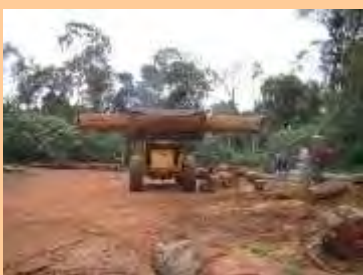
Foto P48: Trabajos de planchada
