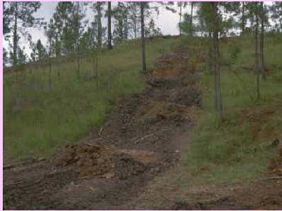
Foto 29: Vía de saca con drenajes transversales
