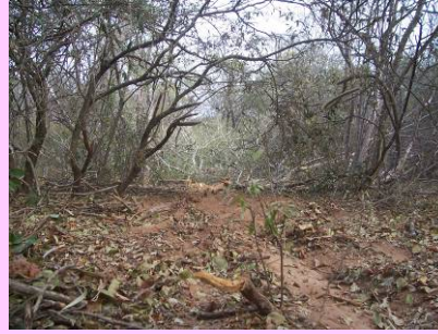
Foto C22: Línea de cable
