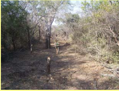
Foto A63: Vía de saca en construcción
