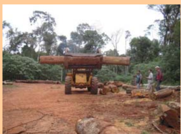
Foto P53: Trabajos de planchada
