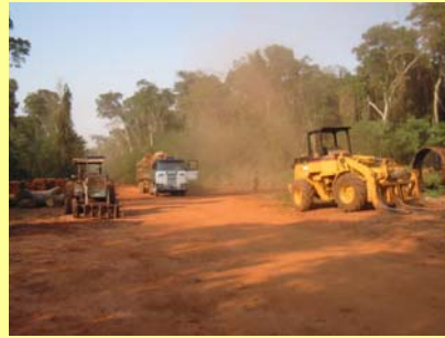
Foto A5: Cancha de acopio
