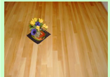
Foto I37: Piso parquet de interior
