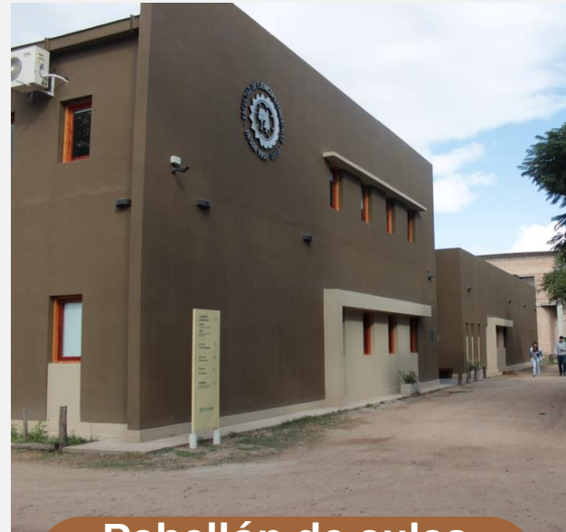
Pabellón de aulas FCF – Zanjón
