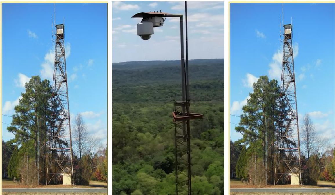
.Figura 3. Torre de vigilancia para operador humano y torres de vigilancia automática.
