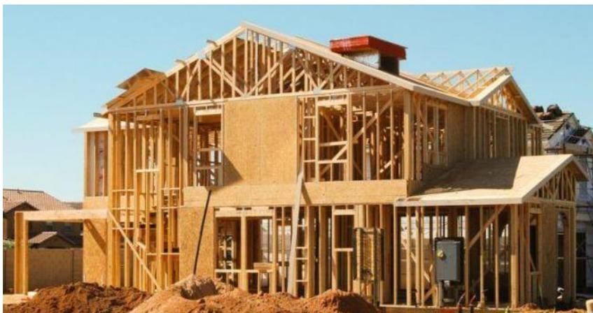
**Figura VIII.14.** Imágenes del sistema Plataforma. Fuente: Madera21 (2025) (a) y Toscana (2020) (b).
