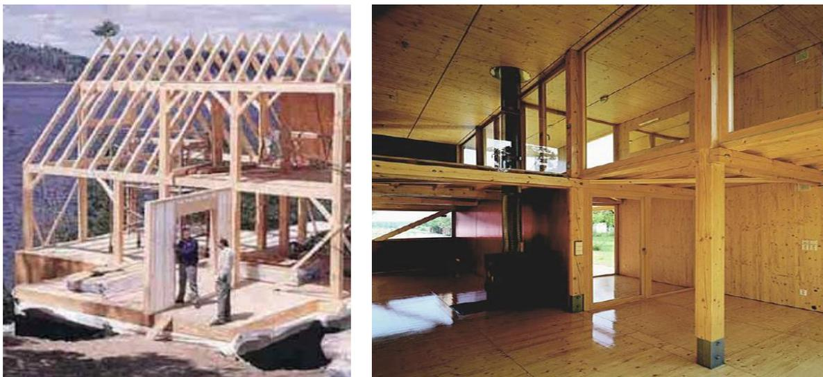
**Figura VIII.11.** Imágenes del sistema poste y viga. Fuente: Apuntes Ingeniero Civil (2011) (a) y Mazzitelli (2020) (b).
