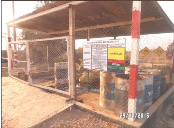
**Figuras N° 12 y 13:** Patios de Residuos Peligrosos en obradores de Empresas operando en Quimilí, Santiago del Estero, en el interior se observa carteles indicando el tipo de residuo acopiado "Y8". Imagen de los Autores año 2.105
