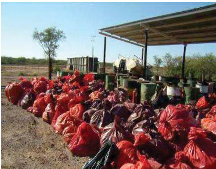
**Figura N° 10:** Almacén de Residuos Peligrosos colapsado, las bolsas están asentadas sobre suelo desnudo, con la consiguiente potencialidad de la contaminación. Imagen de los autores año 2.014
