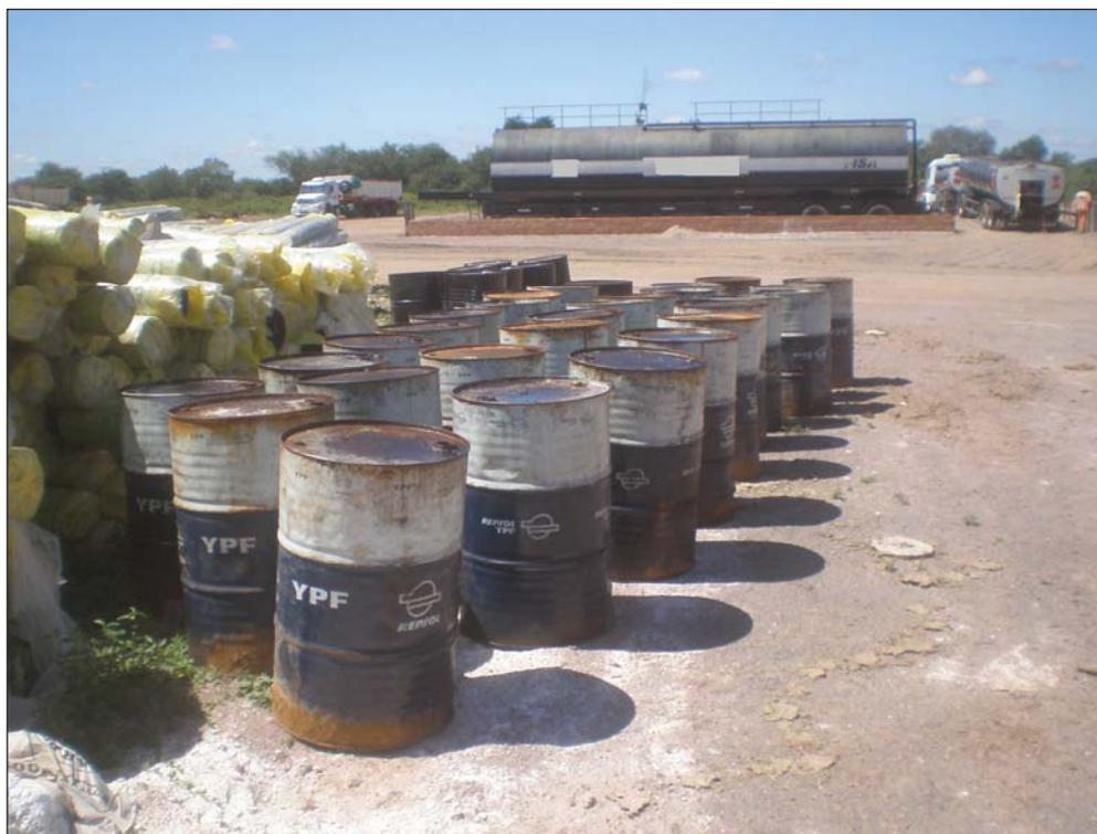
**Figura Nº 17:** Acopio de Aceites de manera inadecuada, sobre suelo desnudo en un obrador durante la construcción de una obra. Imagen de los Autores Año 2016
