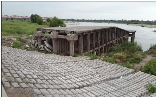
**Figura N° 6:** Espigón el Río Dulce destruido para construir la “Avenida Costanera II”, sobre el margen Derecho del Río Dulce. Se observa el producto de la demolición. Fotografía propia.
