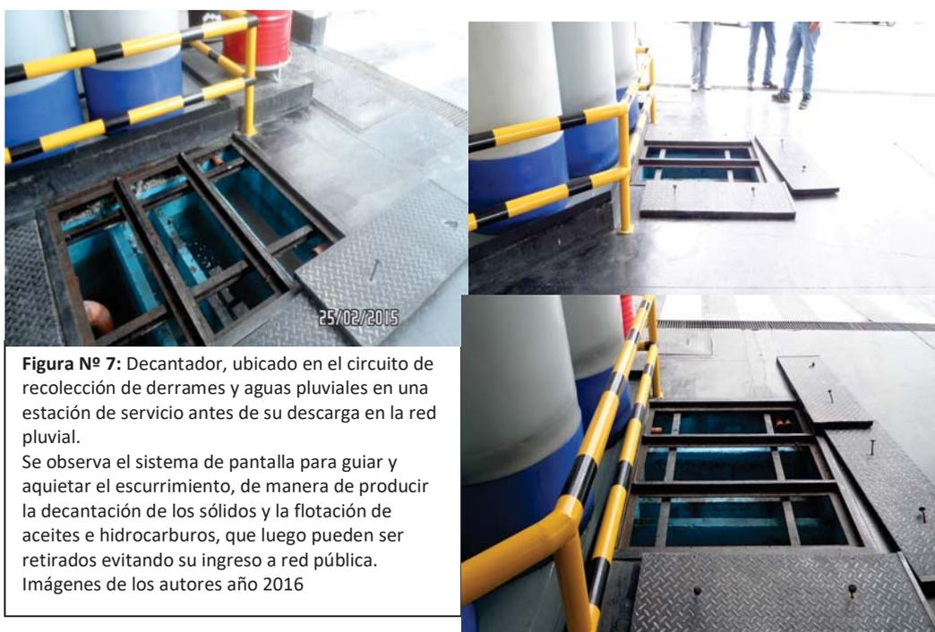
**Figura Nº 7:** Decantador, ubicado en el circuito de recolección de derrames y aguas pluviales en una estación de servicio antes de su descarga en la red pluvial. Se observa el sistema de pantalla para guiar y aquietar el escurrimiento, de manera de producir la decantación de los sólidos y la flotación de aceites e hidrocarburos, que luego pueden ser retirados evitando su ingreso a red pública. Imágenes de los autores año 2016
