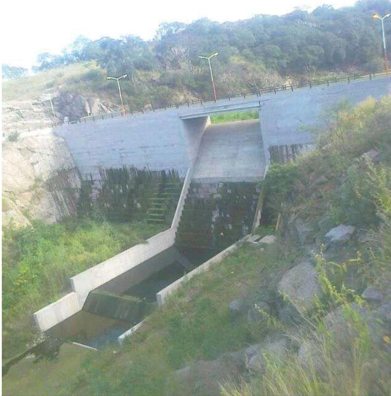
**Figura N° 4:** Vista de la Pared de cierre de la Presa de Embalse. De Villa La Punta, Dpto. Choya, Santiago del Estero. Abril de 2015. Se observan filtraciones en la pared de cierre y en el macizo montañoso afectado para generar el cierre. Fotografía propia.
