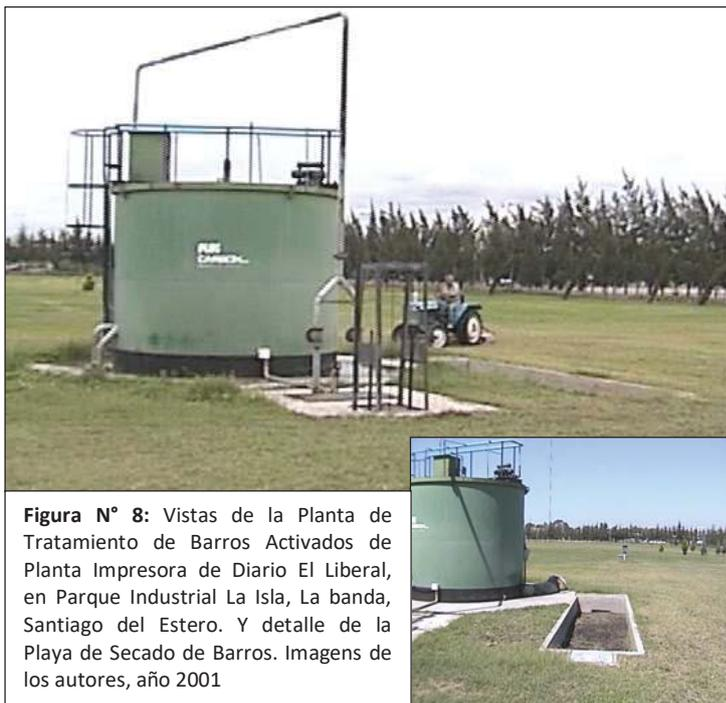
**Figura N° 8:** Vistas de la Planta de Tratamiento de Barros Activados de Planta Impresora de Diario El Liberal, en Parque Industrial La Isla, La banda, Santiago del Estero. Y detalle de la Playa de Secado de Barros. Imagens de los autores, año 2001
