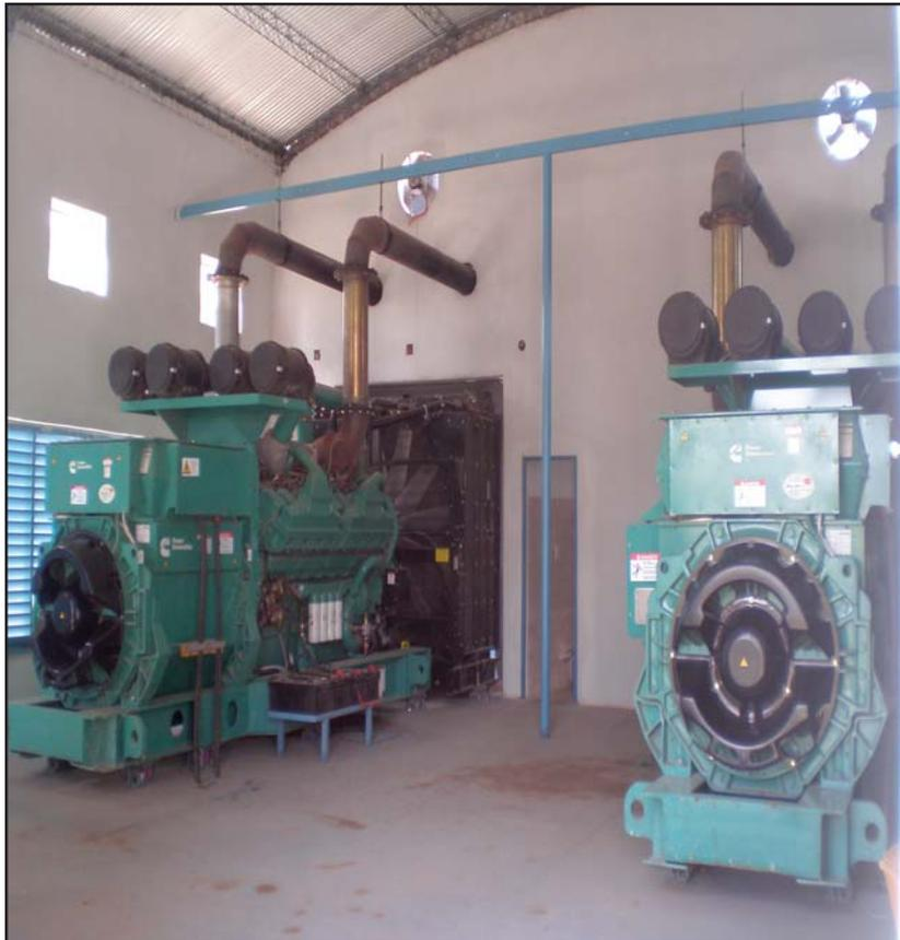
**Figura N° 3:** Grupos electrógenos, abastecidos por motor combustión interna que funcionan con Gas Oil. Ambos entregan Energía eléctrica a la ciudad de Bandera, Departamento Belgrano, Santiago del Estero. Imagen tomada por los Autores en el año 2.010.
