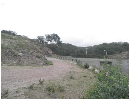
Figura 24. Embalse de aguas de vertientes en el sur de las Sierras de Guasayán
