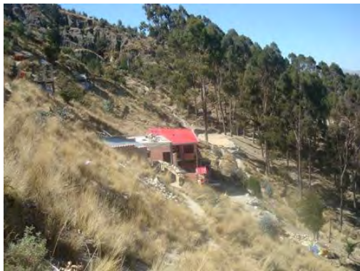
Fig. 1. Paisaje fragmentado por la construcción de vivienda - Área periurbana 27 de marzo
